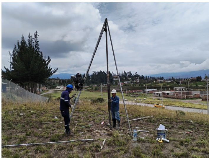
Fotografía 3.- Trabajos de campo sondeo SM-3
