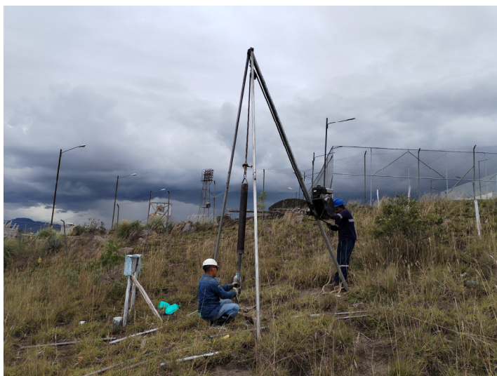
Fotografía 4.- Trabajos de campo sondeo SM-4
