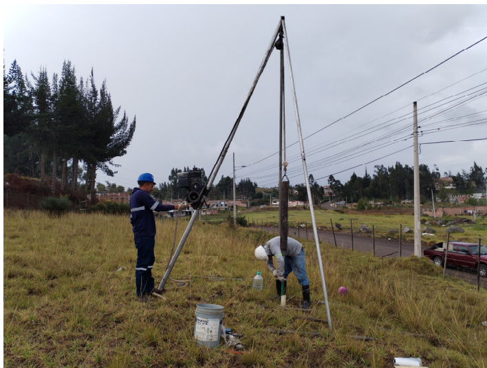
Fotografía 1.- Trabajos de campo sondeo SM-1
