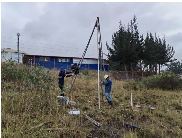
Fotografía 2.- Trabajos de campo sondeo SM-2
