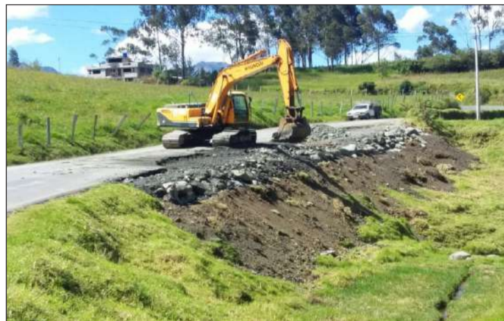
► Maquinaria y técnicos se encuentran trabajando en el sitio.
