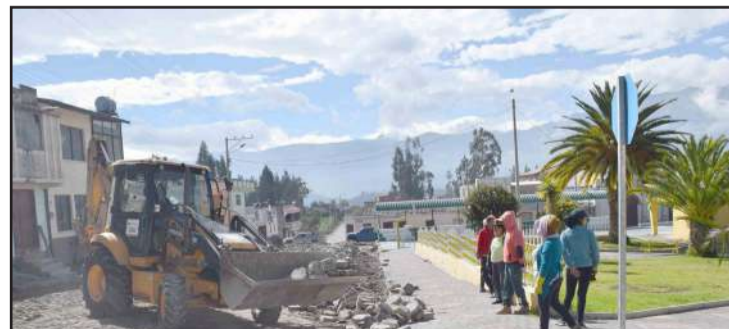
Maquinaria trabaja retirando los adoquines.
