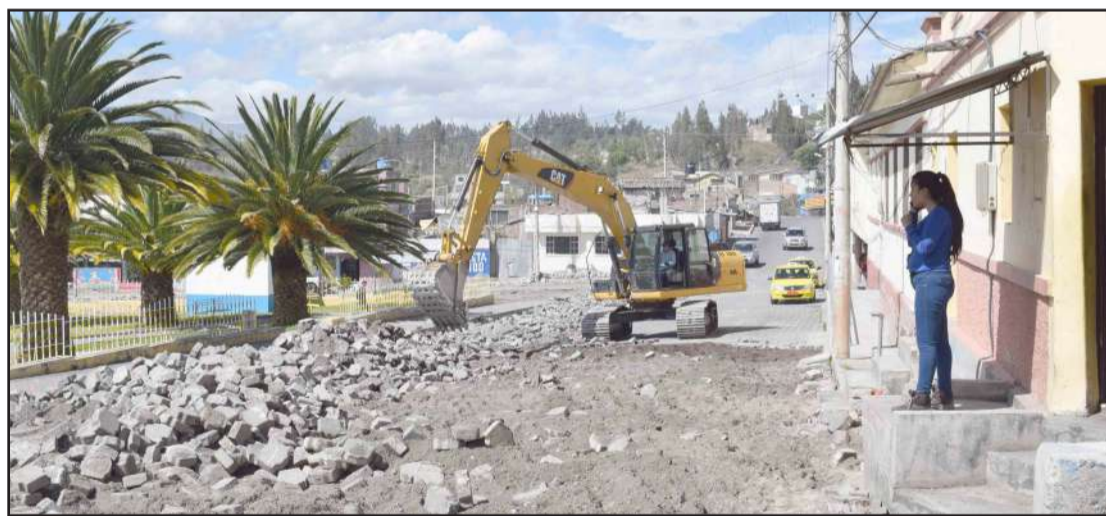
Trabajan en el retiro de los adoquines en el sector del parque de San Gerardo.
