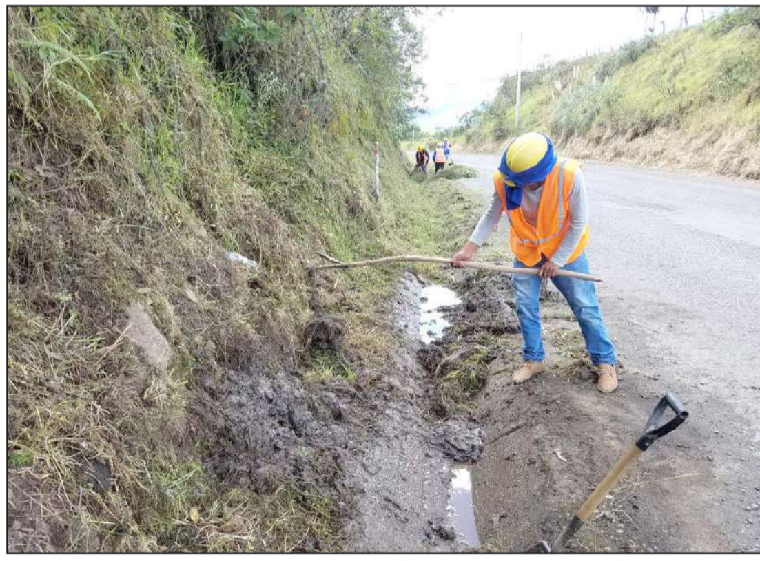
► Los trabajos se concentraron en los tramos Alausí-Huigra, San Luis Socavón, Panamericana-Cecao-Troje y Palmira
