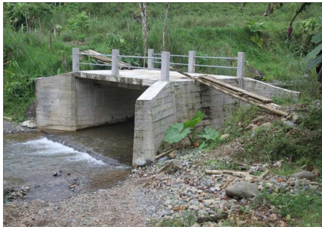
► Esta obra facilitará el tránsito hacia varios recintos.
