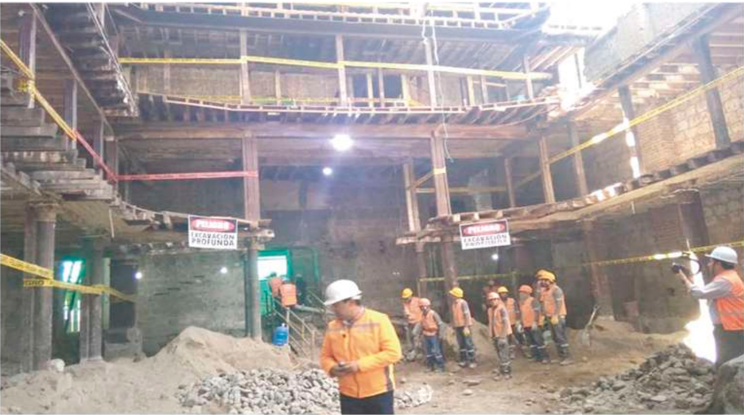
Trabajos realizados en la rehabilitación de esta obra emblemática para la ciudad.
