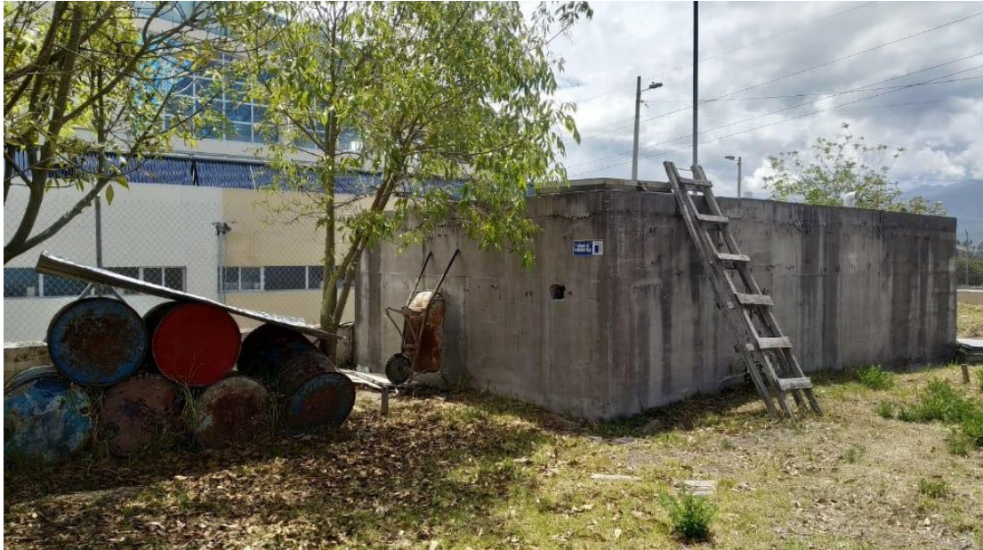
Ilustración 2. Área de almacenaje de combustible
