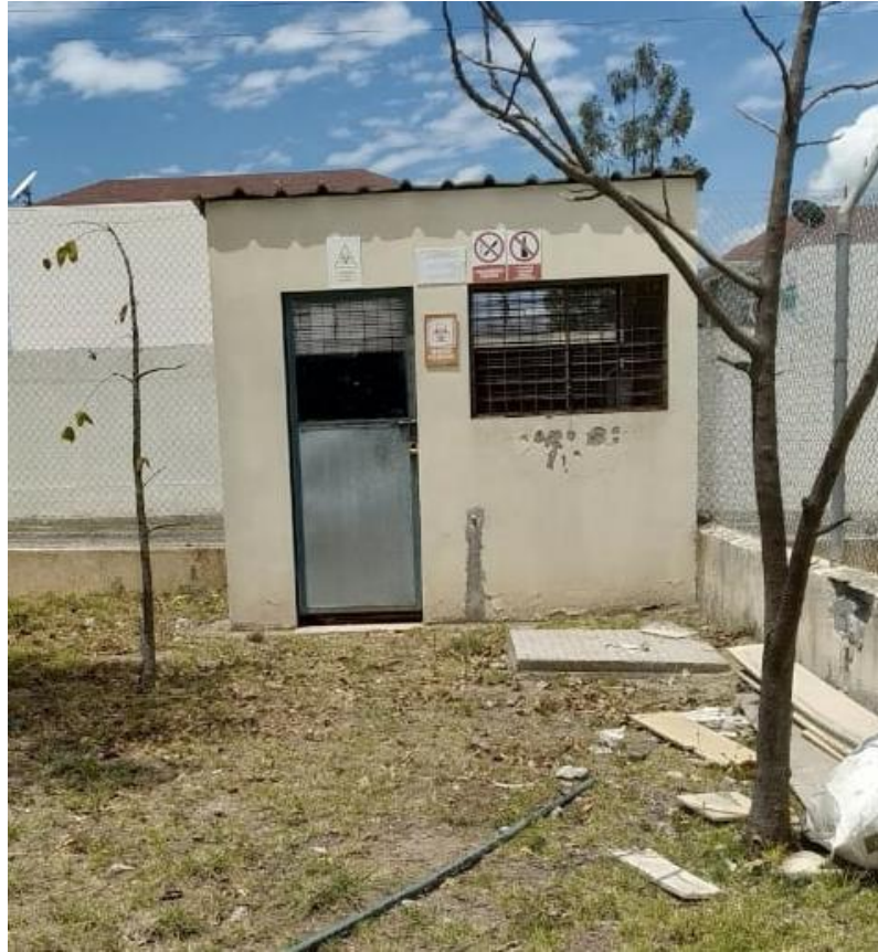
Ilustración 3. Área de almacenaje de residuos peligrosos
