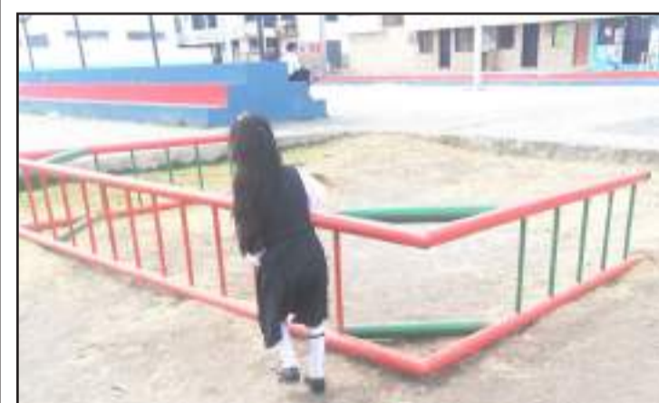
El parque no ha recibido mantenimiento en los juegos.
