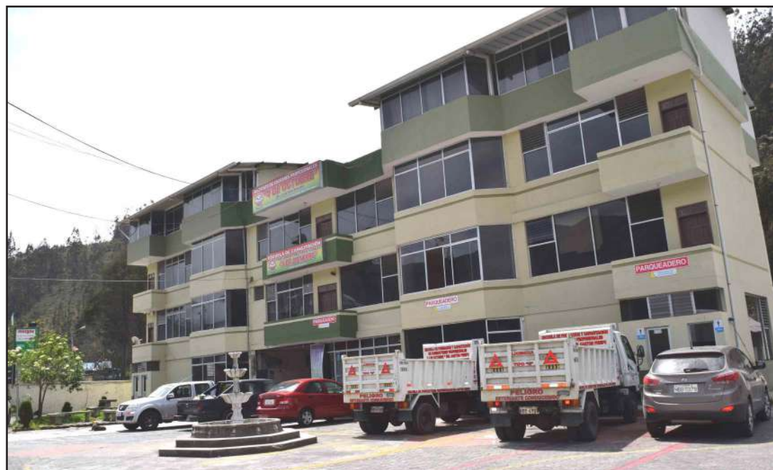
► Edificio del Sindicato de Choferes del cantón Penipe.
