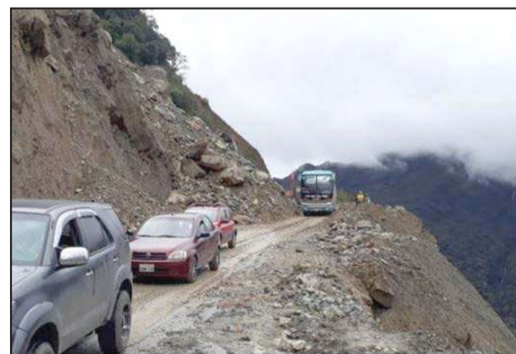
► Maquinaria continúa con el desalojo de material.
