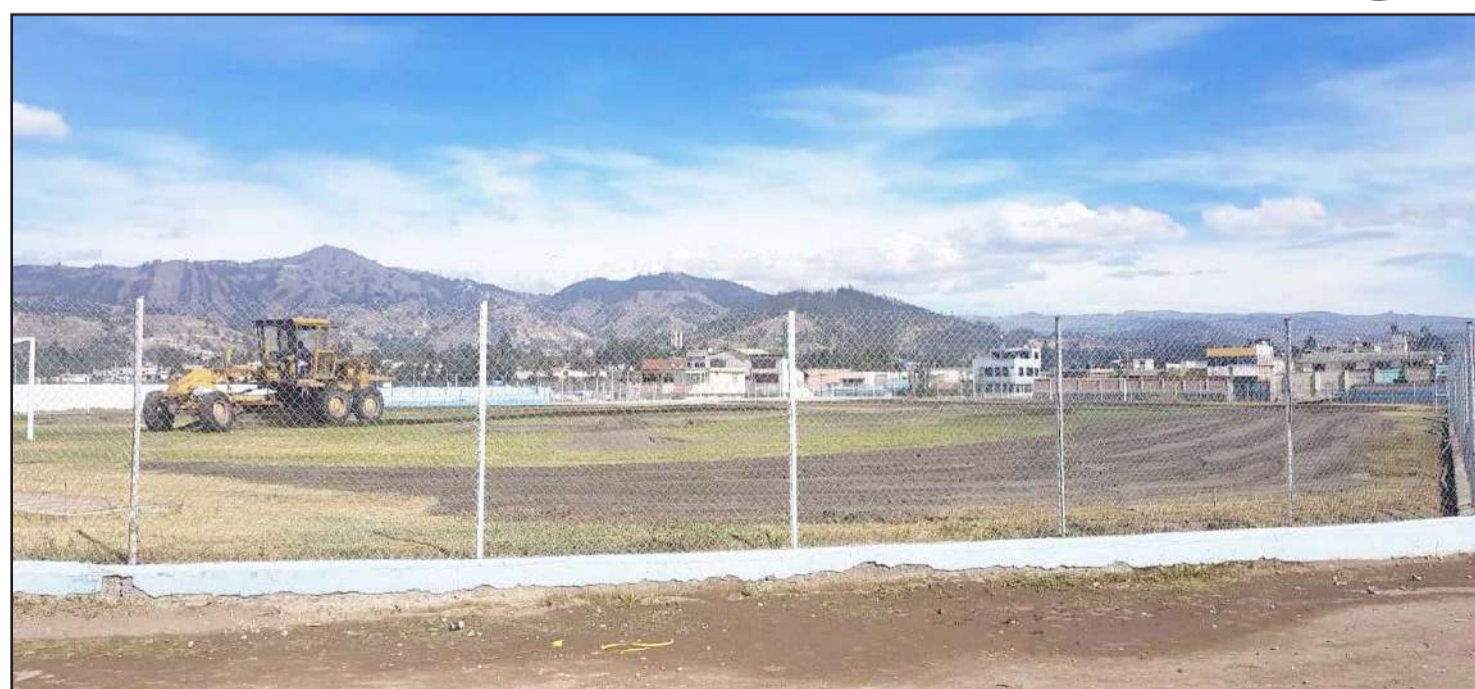
► Maquinaria realiza trabajos en el estadio.
