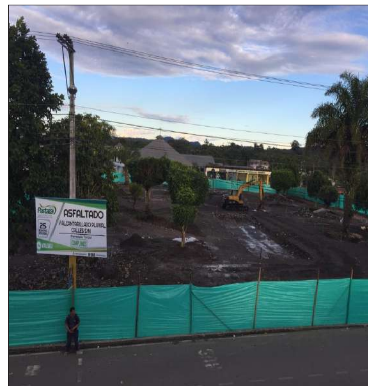
▶ Parque en remodelación en la parroquia Tarqui.
