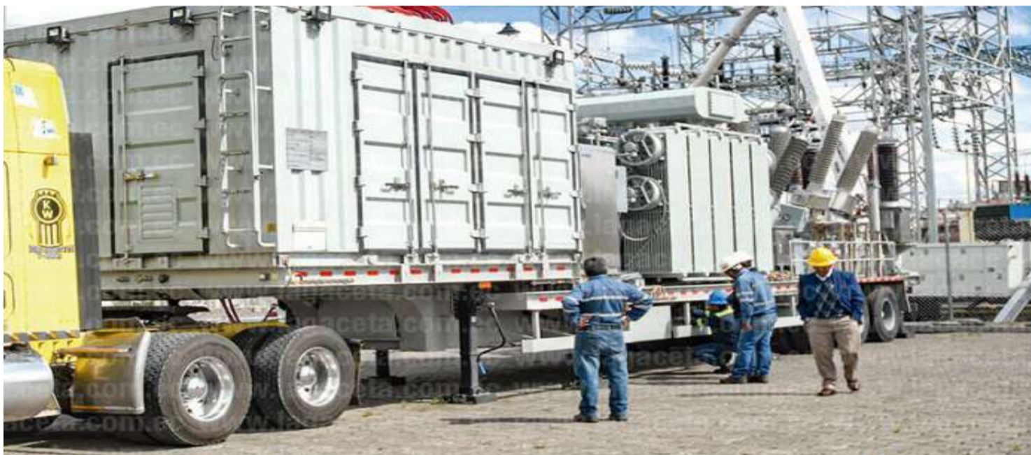
► Momentos en que la subestación móvil era trasladada hacia el cantón Salcedo. FOTO W.C. LA GACETA
