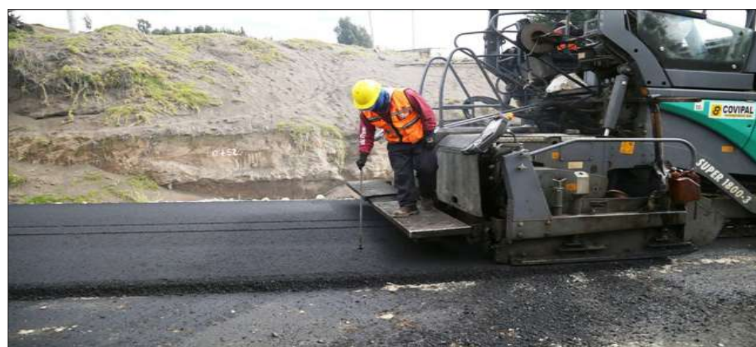
► Personal técnico del GADPCH junto a la maquinaria en el asfaltado de vía Guamote Chacaza.
