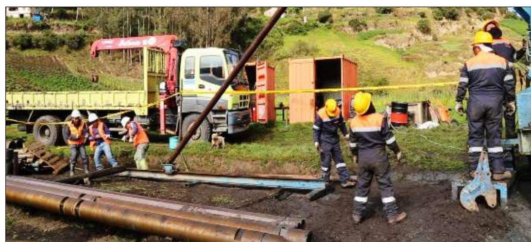
► GADPCH instaló agua subterránea para comunidades de Flores”.
