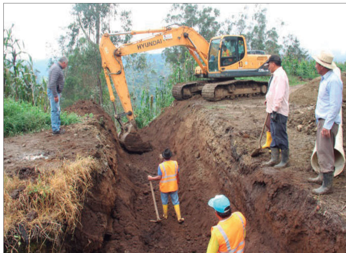
La maquinaria asignada para este trabajo es una retroexcavadora y volqueta.
