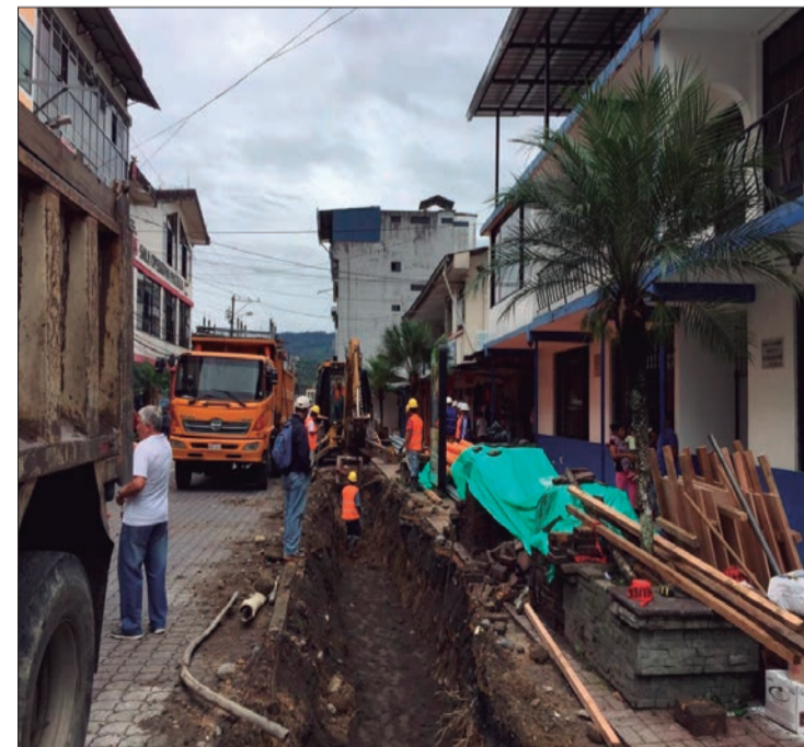
► Han comenzado los trabajos en las calles Atahualpa y Diez de Agosto.
