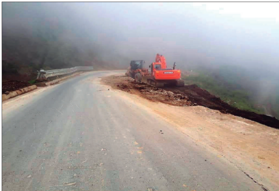
► Maquinaria avanza en la reparación de la alcantarilla colapsada.
