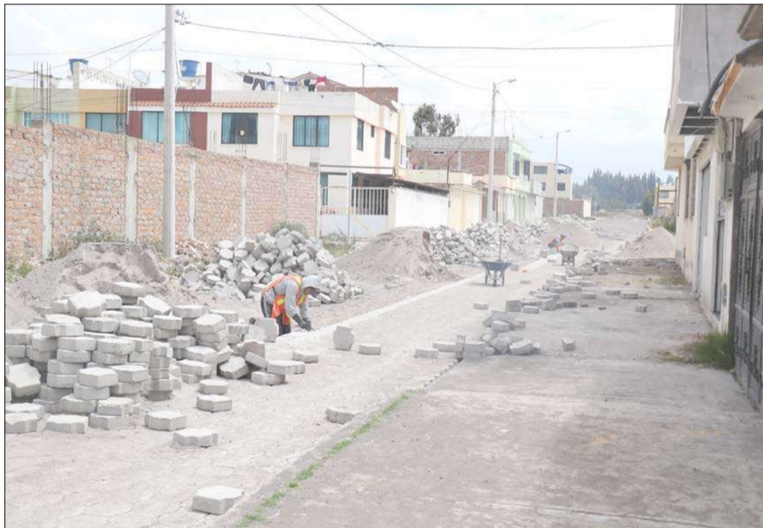
► Trabajos de adoquinado se cumplen en diferentes vías del barrios Cisneros de Tapi.
