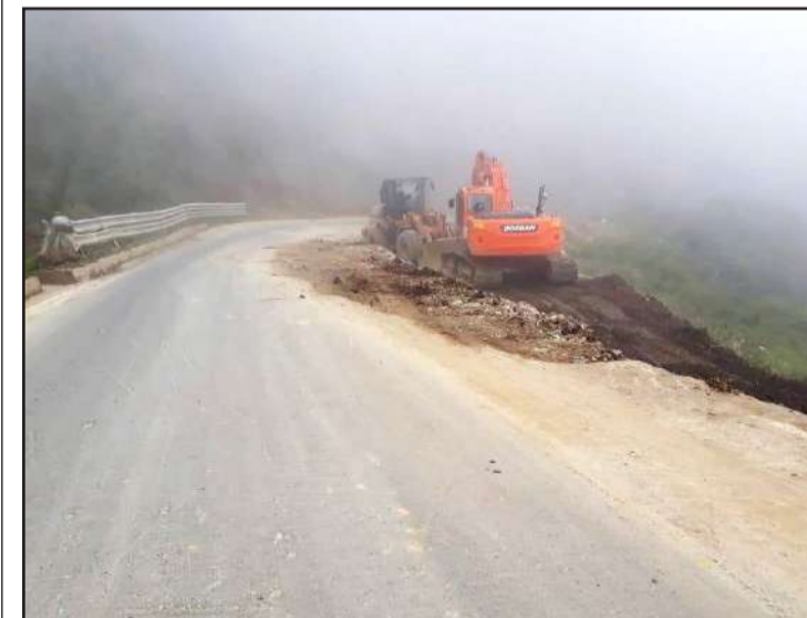
► Maquinaria del MTOP realiza los trabajos.
