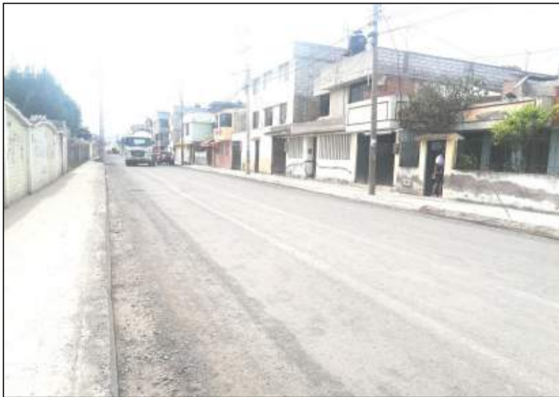
Los trabajos se realizan hasta los fines de semana para acabar de manera breve.
