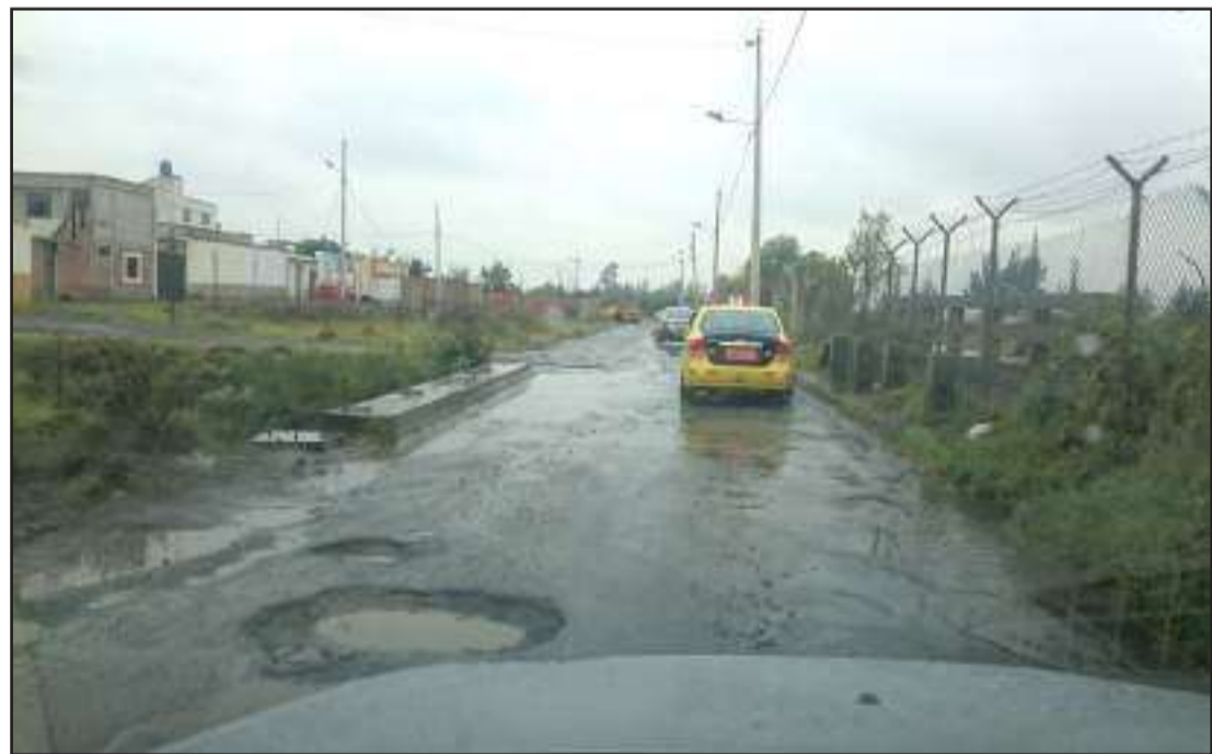
Al momento las calles que están tras las mallas del cuartel están deterioradas.
